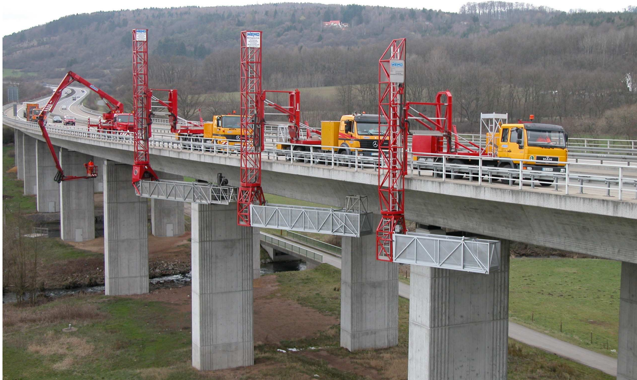
Německá firma WEMO-tec vlastní 35 mostních prohlížeček, vyrobených firmou MOOG. Kterýkoli z těchto strojů může pracovat i na území ČR.
